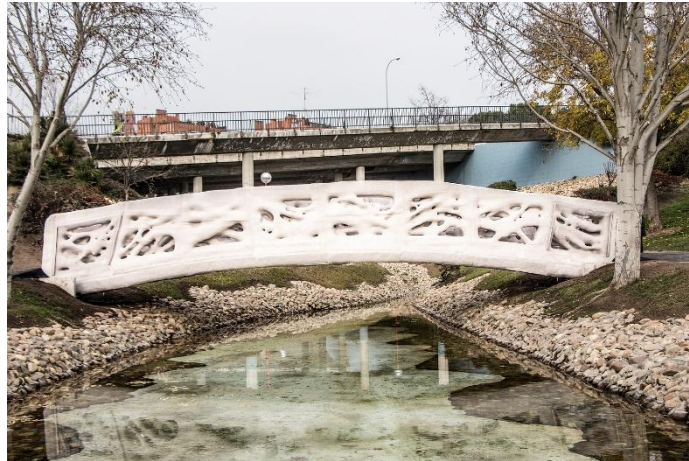
2. ábra: A 3D híd kinyomtatva
