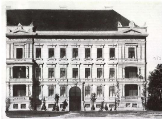
1. sz. kép: A Mayer-ház (Feszl Frigyes 1883-84) Bajza u. felőli homlokzata
