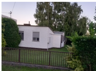
Nyaraló a 60-as évekből. Építette: Harmat Lajos kőműves-és ácsmester. (Az utcafront felőli felújítás az eredetivel megegyező.)
